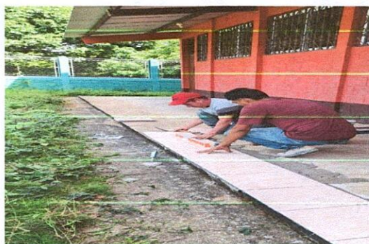
Foto 6: Sustitución de piso de concreto de acabado liso por piso cerámico en la cocina y corredor.
