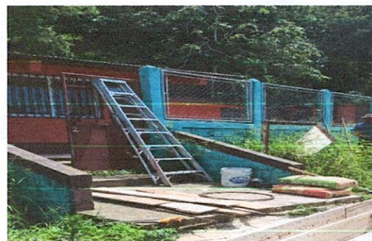
Foto 4: Mantenimiento a portón de ingreso, material: metálico, incluye: bisagras y sistema de cierre.
